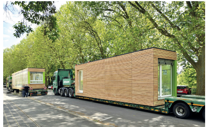
Figura 10: Moduli in legno sul rimorchio di un autocarro
