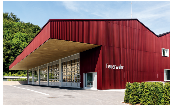
Figura 6: Centro di manutenzione nel Comune di Kriens (LU)
