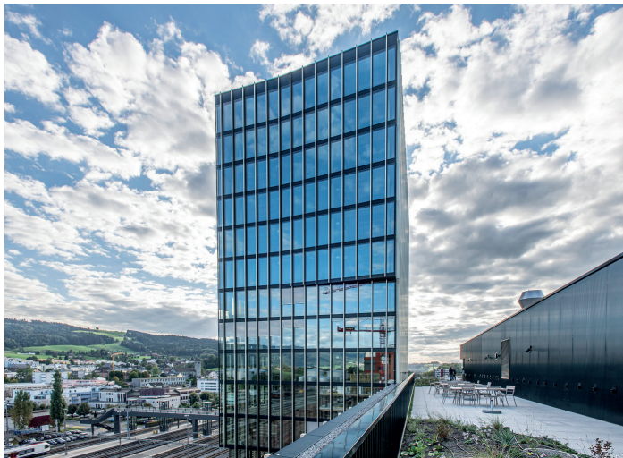
Figura 19: Edificio multipiano Arbo, Rotkreuz (ZG)
