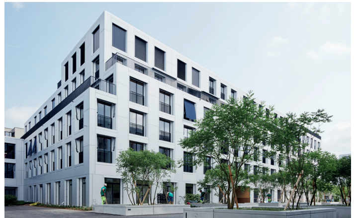
Figura 3: Complesso residenziale Sue & Til, Winterthur
