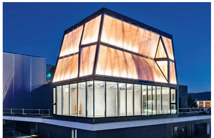
Figura 15: DFAB House, edificio NEST, Empa, Dübendorf (ZH)
