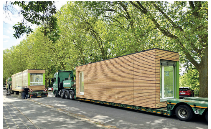
Illustration 10: pièces modulaires en bois sur des remorques une quarantaine de chambres.
