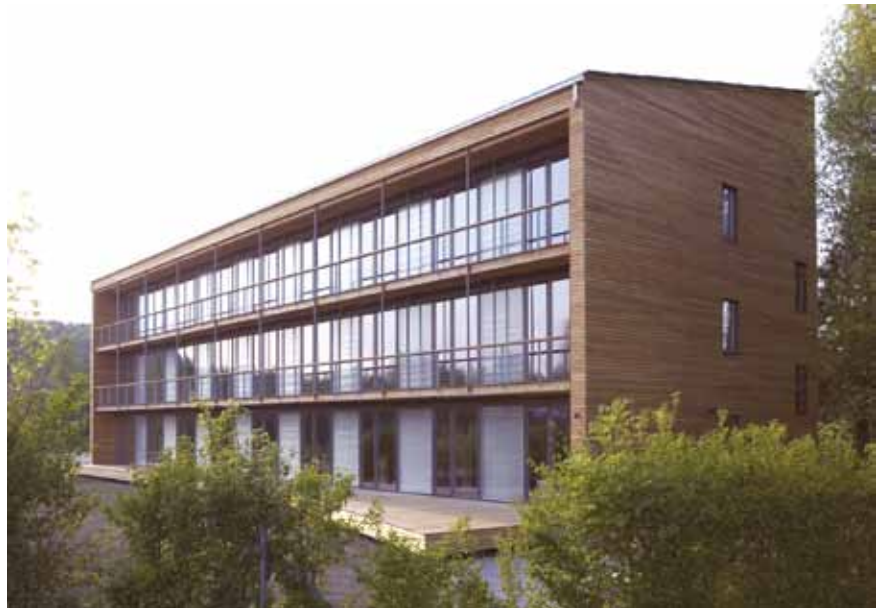
Abb. 15: Verwaltungsgebäude von Marché International in Kemptal
