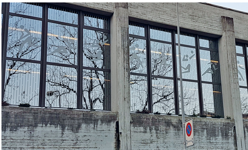
Abbildung 6: Sporthallen sind wegen starker Spiegelung auf grosser Fläche oft eine Gefahr. Hier wurde mit Kristallfolie vorbildlich nachgerüstet. © Dominik Rüede
