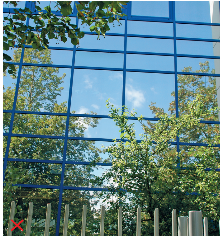
Abbildung 11: Stark spiegelndes Sonnenschutzglas in Kombination mit Bäumen – für Vögel eine tödliche Falle. © Archiv Schweizerische Vogelwarte
