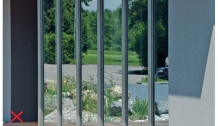
Abbildung 10: Aufgrund des hohen Reflexionsgrades wird die Umgebung auf den Scheiben realitätsnah abgebildet. Eine tödliche Gefahr für Vögel. © Archiv Schweizerische Vogelwarte
