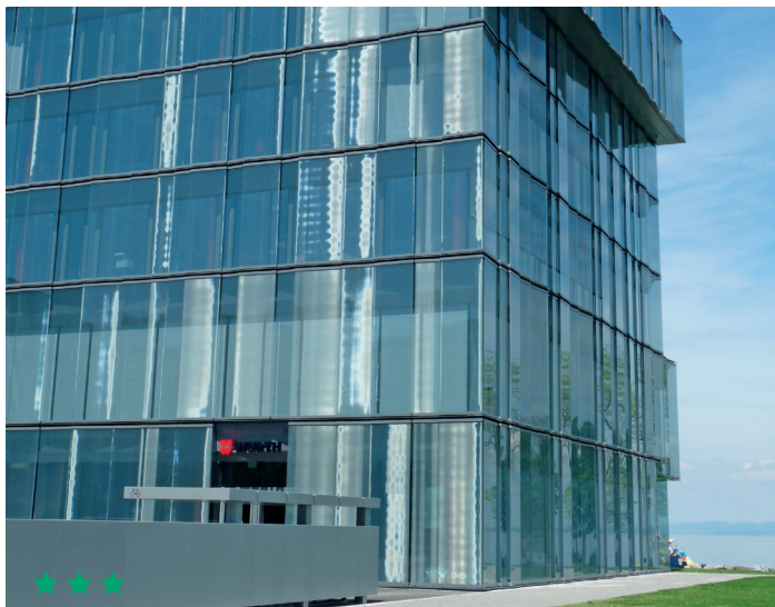
Abbildung 9: Gebäudehülle mit metallbedampftem Gewebe im Scheibenzwischenraum. Eine Überwachung während eines Jahres bestätigte, dass es zu keinen Kollisionen kam. © Archiv Schweizerische Vogelwarte
