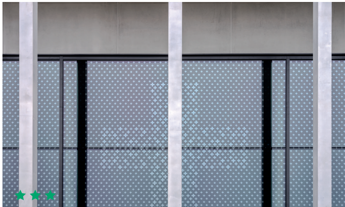
Abbildung 8: Eine vorbildliche Umsetzung findet sich auch auf dem Waffenplatz Frauenfeld: die Glasfront des Verpflegungszentrums ist mit einem Muster versehen, womit Vogelkollisionen vermieden werden können. © René Dürr
