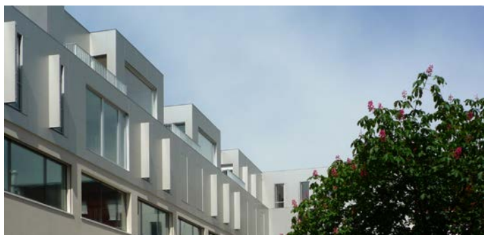
Abb. 4: Les Marronniers (Quelle: U15 Architectes)
