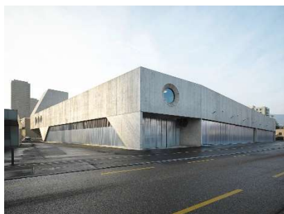
Deposito per bus, Zurigo-Hardau. Rappresentante del committente: Amt für Hochbauten (foto: Andrea Helbling Arazebra, Zurigo)
