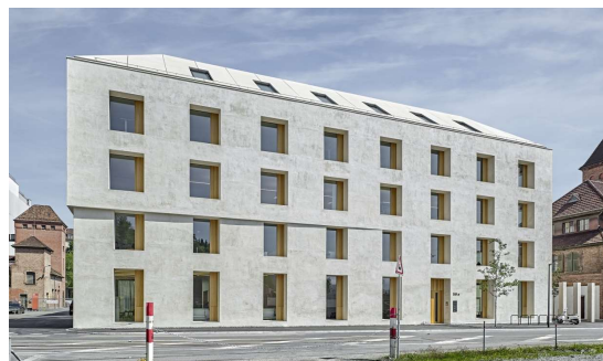
«Baukonzept 2226»: edificio amministrativo, Emmen (LU)
