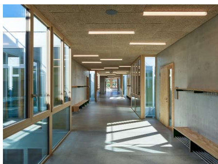
Calcestruzzo con aggregati riciclati, edificio scolastico Brühl, Gebenstorf (AG)
