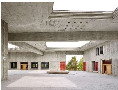
Edificio scolastico Schauenberg, Zurigo-Affoltern. Rappresentante del committente: Amt für Hochbauten (foto: Roland Bernath, Zurigo)
